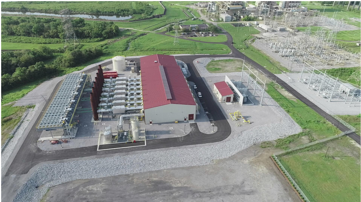
Drone photo of NOPS Site (August 2020)
